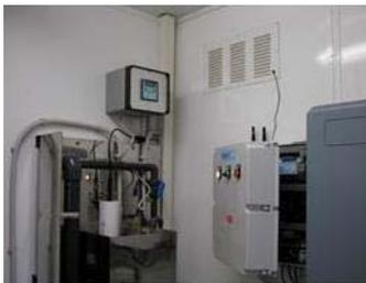
Gestione remota di stazioni idro-meteorologiche complesse con analizzatori in cabina prefabbricata e climatizzata.
